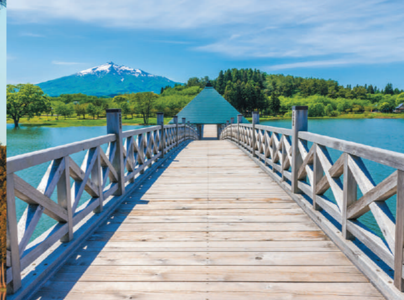
橋の欄干は、木組みにクロスが取り入れられた、和洋折衷のデザイン。
