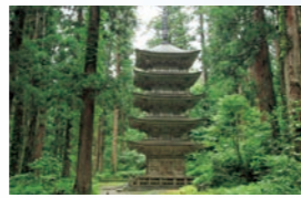
6 羽黒山五重塔 屋根は日本古来の柿葺。三間五層の色彩を施さない素木造りを用いる。(国宝)
