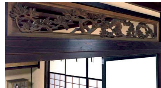
6 町家の彫刻欄間
